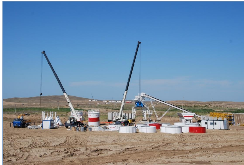
Мобилизация – новая бетонная установка
