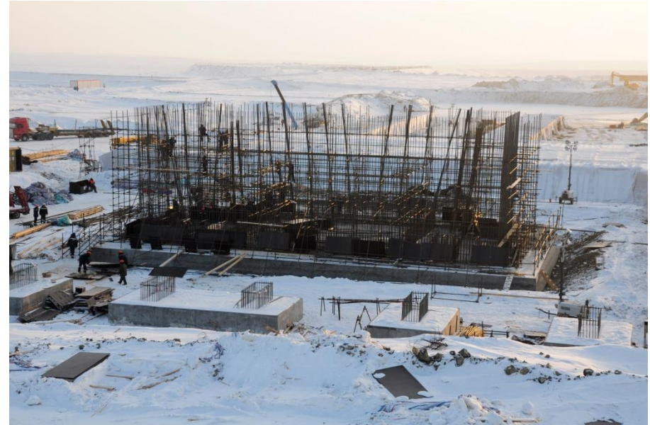
Фундаменты для ОФ для переработки сульфидной руды в Актогае
