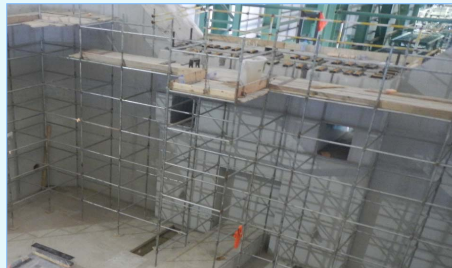
Установка отдельных плит на мельнице частичного самоизмельчения
