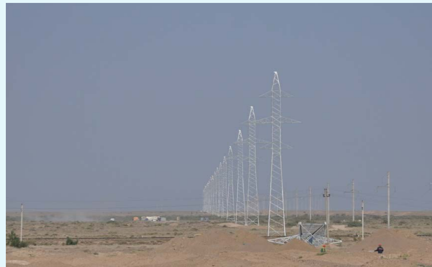
Линия электропередач на 110 кВ (50% завершено)
