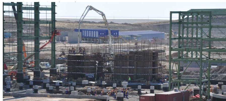
Участок флотации и измельчения, фундаменты и стальные конструкции
