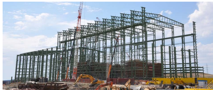
Металлоконструкции обогатительной фабрики
